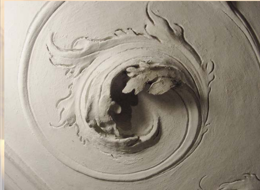
FIGURE 6: Santino Bussi (1664-1736) Stucco detail in the Sala Terrena of the Garden Palais Liechtenstein, after 1700, Vienna, Austria (©Sammlungen des Fürsten von und zu Liechtenstein, Vaduz. URL http://www.liechtensteinnmuseum.at )
